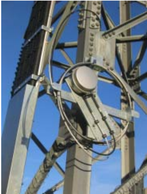
Skarvbox för OPGW monterad på stolpfäste 800
